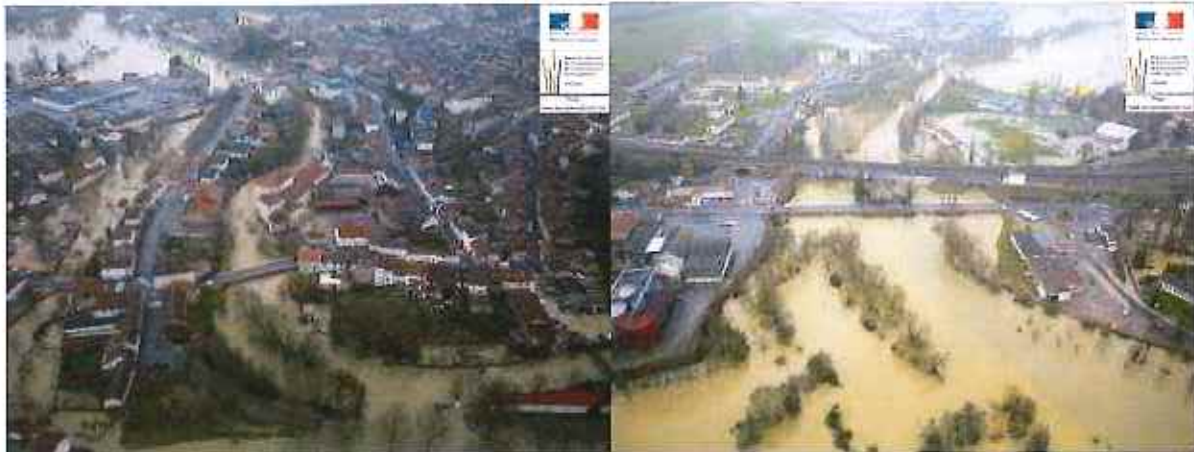
Figure 9 : Photographies aériennes de la crue de la Meuse de décembre 2011 à Neufchâteau (DREAL Lorraine, 2011)
